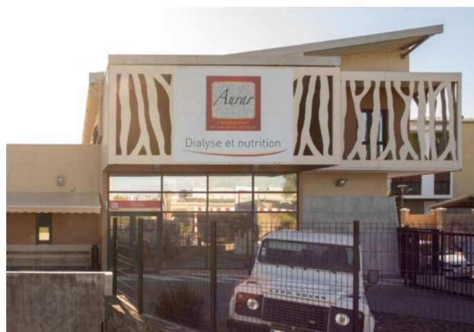
Le site de l'Aurar à Saint-Louis accueille un dispositif de panneaux photovoltaïques.
